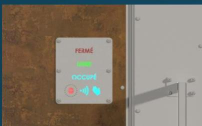
Un panneau signalétique lumineux à l'extérieur informe l'utilisateur de l'état des WC : « LIBRE », « OCCUPÉ » ou « FERMÉ ». Grâce à un interrupteur sans contact, l'utilisateur provoque l'ouverture de la porte.
